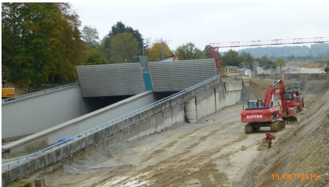
Foto: Bau der Umfahrung der Richtungsfahrbahn München bei Etterschlag, Christian Hocke, Autobahndirektion Südbayern
