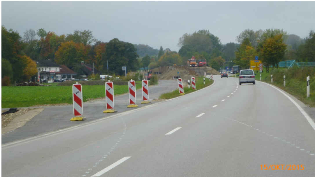
Foto: Provisorische St2070 bei Eching, Christian Hocke, Autobahndirektion Südbayern
